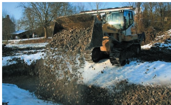
Apport de matériaux grossiers dans le nouveau lit du ruisseau en janvier 2009.
