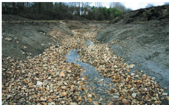
Le nouveau lit du cours d'eau, en janvier 2009, après l'apport de matériaux. Les matériaux sont disposés dans le lit, à l'aide d'une pelle mécanique, de manière à recréer un lit mineur d'étiage.
