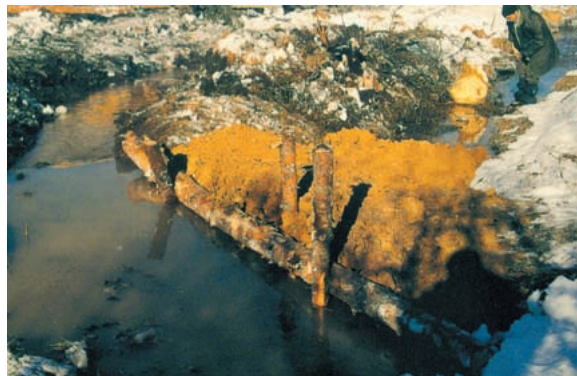
Pose d'un bouchon marneux à l'intersection entre le lit rectiligne et les méandres du cours d'eau.
