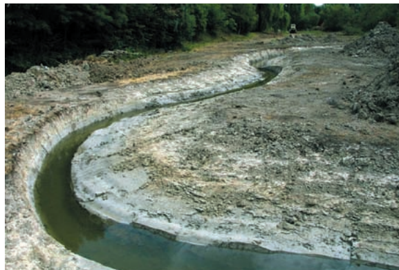
Creusement et terrassement du nouveau lit du cours d'eau dans les vases d'un ancien étang.
