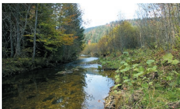
Pose de banquettes dans le lit rectifié pour rediversifier les écoulements.
