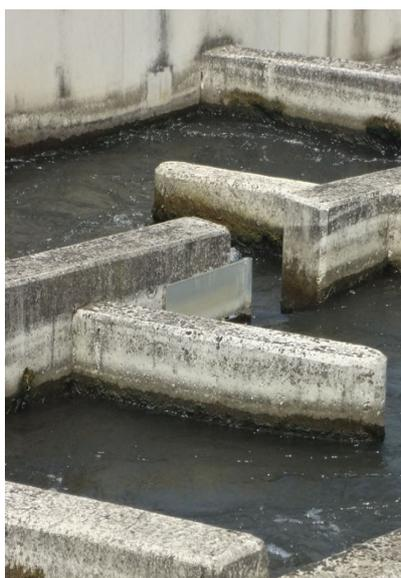
Dispositif de [franchissement piscicole](#) pouvant incorporer des [dispositifs de comptage](#)
